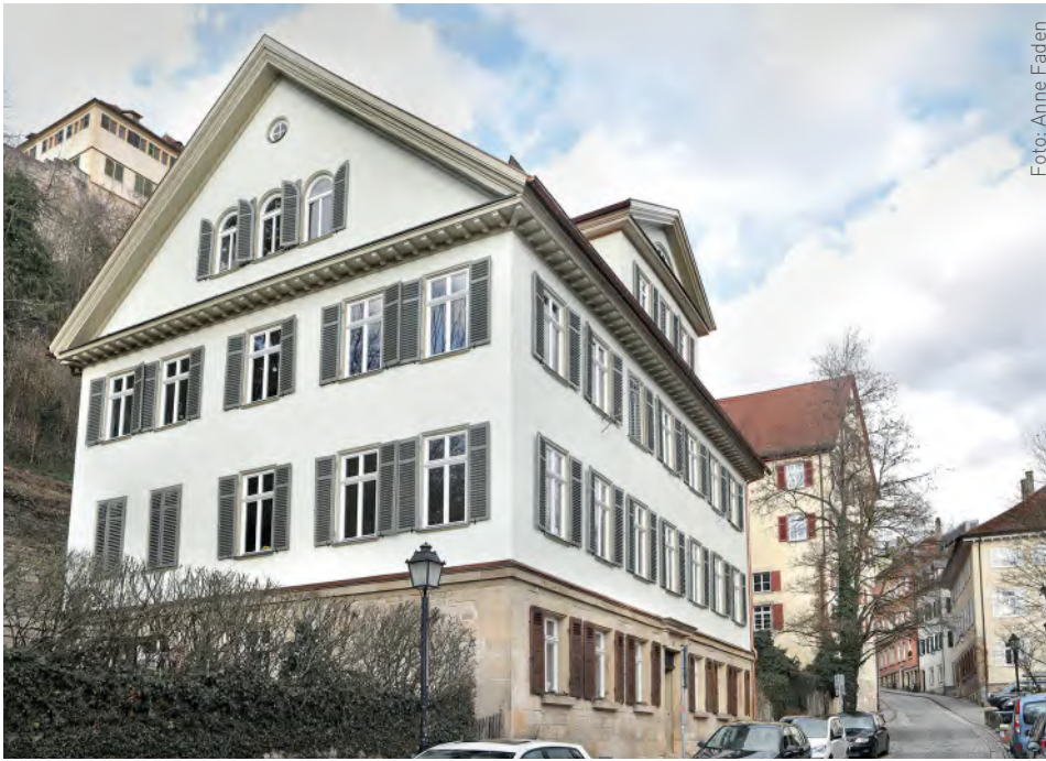
Neckarhalde 32 in Tübingen nach der Sanierung mit Aerogel-Dämmputz.
