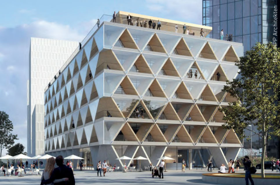
Im Düsseldorfer Medienhafen planen HPP Architekten für die INTERBODEN Gruppe Düsseldorf's erstes Bürogebäude in Holzhybrid-Bauweise – in vielerlei Hinsicht ein zirkuläres Pilotprojekt.
