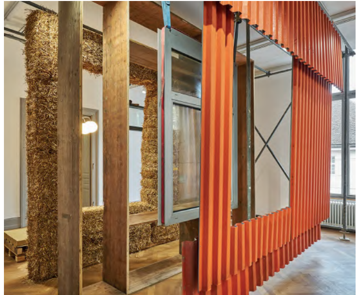
Die Aufstockung „K118“ in Winterthur erfolgte mit kreislauffähigen Baustoffen – das Fassaden-Mock-up zeigt den Wandaufbau.
