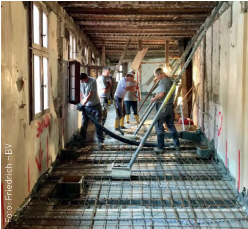
Foto: Friedrich HBV Gasthaus zur Schranke: Beton wird vergossen und verteilt.
