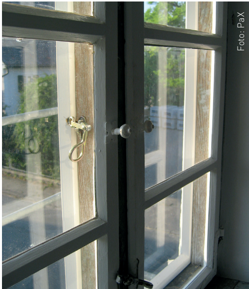
Mit zusätzlichen Fensterflügeln lässt sich ein Bestandsfenster zum Kastenfenster erweitern.
