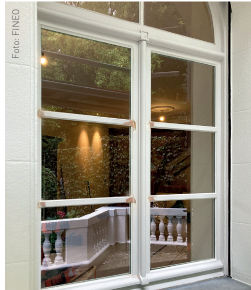
Historischer Rahmen, hochwärmedämmendes Glas: Vakuumverglasung im Originalrahmen.
