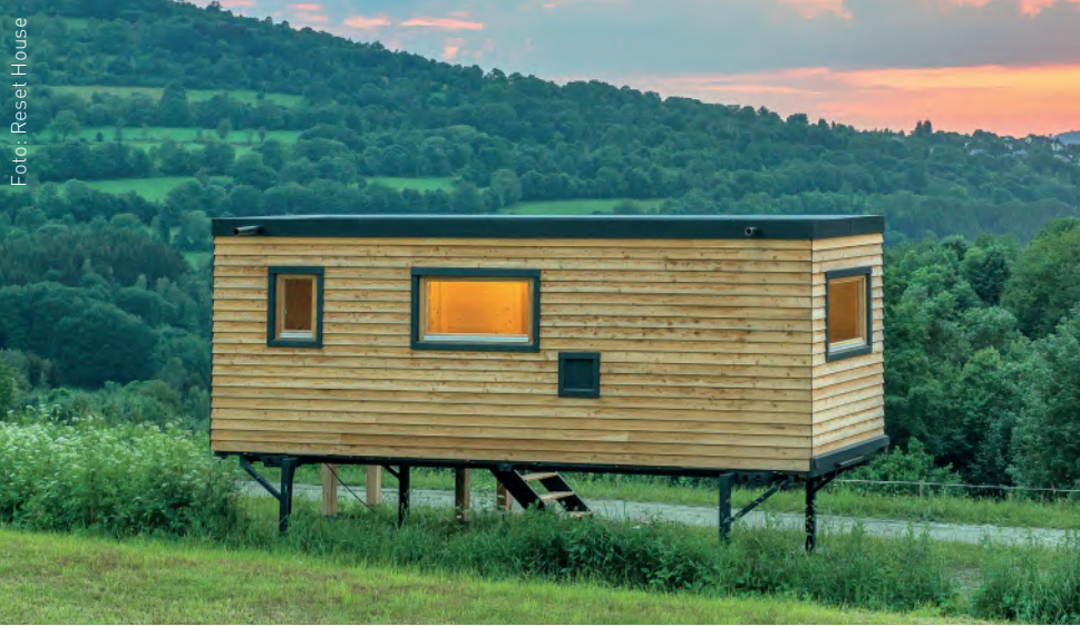
Beispiel Reset House: Wird das Tiny House auf einer genormten Wechselbrücke gebaut, ist der Transport besonders einfach.
