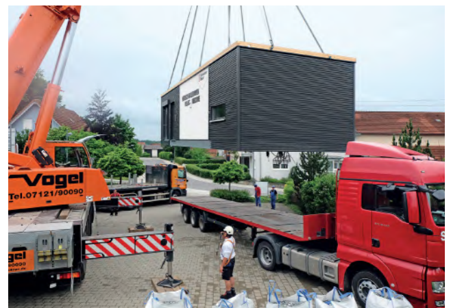
Beispiel FlyingSpace: Die Module werden bevorzugt nachts transportiert und an Ort und Stelle mit Kran platziert.
