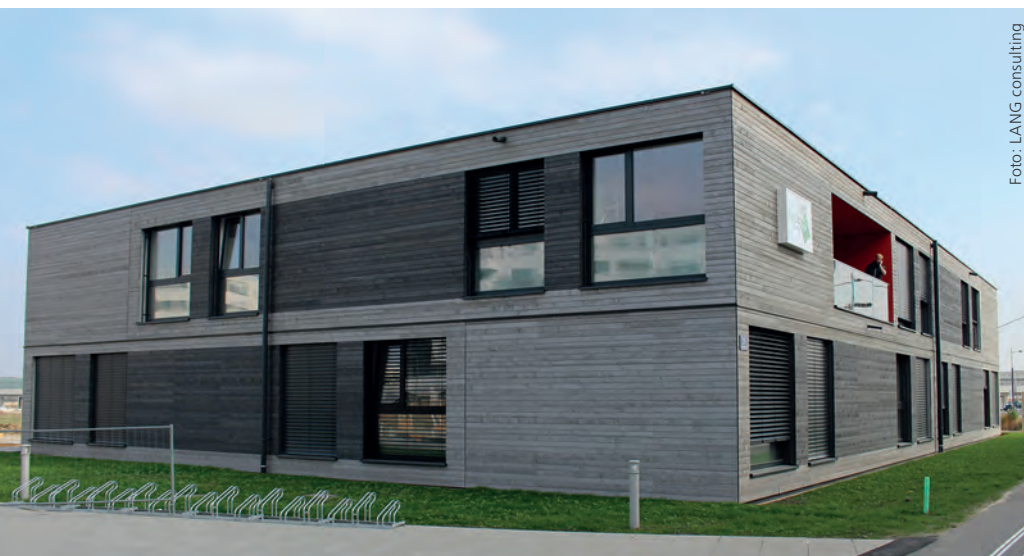
Das Studierendenwohnheim „PopUp dorms“ in Wien-Aspern kann jederzeit ab- und woanders wieder aufgebaut werden.
