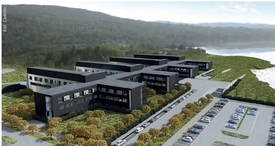
Auch das Passivhaus-Krankenhaus im norwegischen Kirkenes ist in Modulbauweise entstanden.
