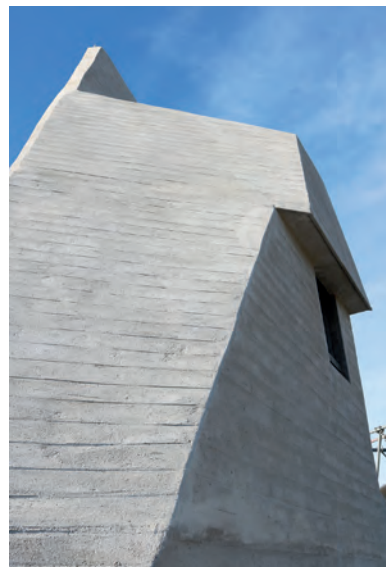
Der Mariendom in Neviges vor und nach der Sanierung
